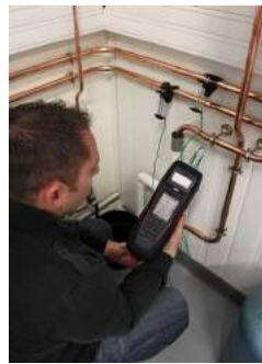
Pomiar temperatury ciepłej wody użytkowej
